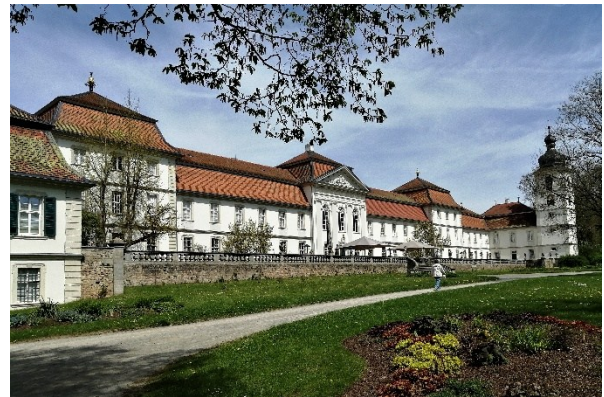
Schloss Fasanerie, Ansicht Terrassenseite
